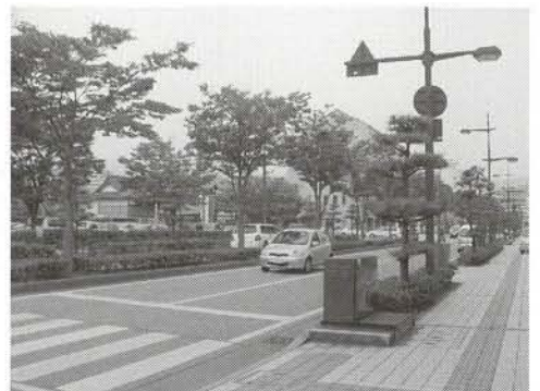
CAB方式で電線地中化された彦根駅前道路
