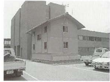
滋賀県立大学の免震実験建物
