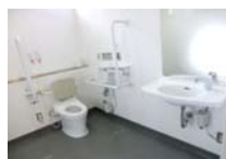
障害者用トイレ
