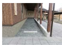
スロープ、手すり
