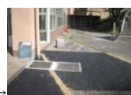
施設老朽化による段差解消
