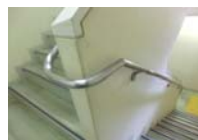
階段手摺の設置
