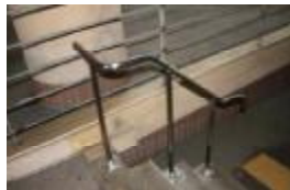
[手すりの設置]
