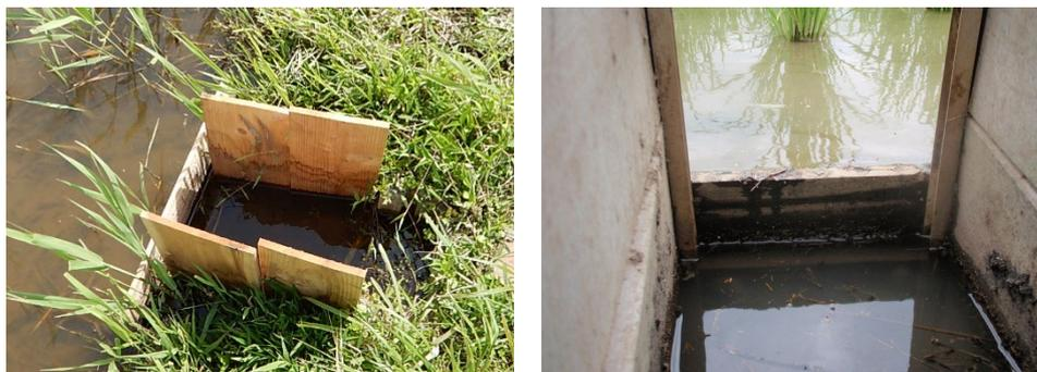
図4.1.10 排水柵の堰板(左, 基準水位以上に高い; 右, 最適な高さ)
