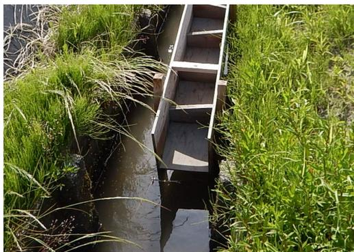
図 4.1.23 排水路水位の低下により遡上口が干出した魚道
