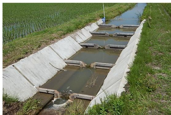
図4.1.6 10cmずつ階段状に堰上げた排水路
