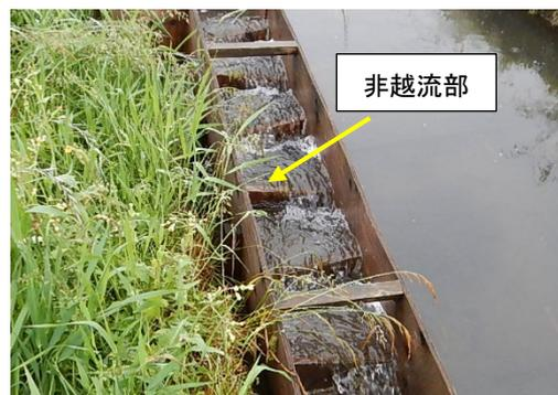
図 4.1.21 堰板斜辺角度 11°，堰板幅 30 cm の魚道の越流状況（越流量 2.5L/s）
