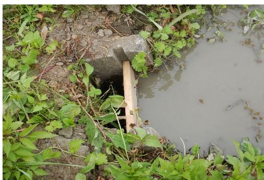
図 4.1.25 排水柵からの越流防止の堰板
