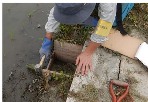
図 4.1.26 水田進入口堰板の高さ調整
