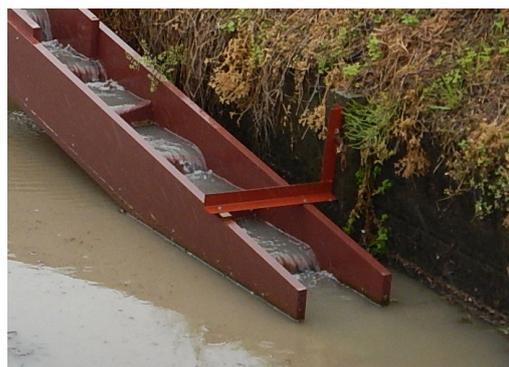
図 4.1.24 排水路水位の低下時にも最下段の堰板までが水に浸かっている魚道
