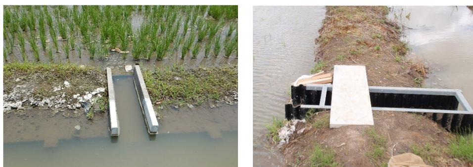
図4.1.12 U字溝 (左) やコルゲート管 (右) による進入口の増設
