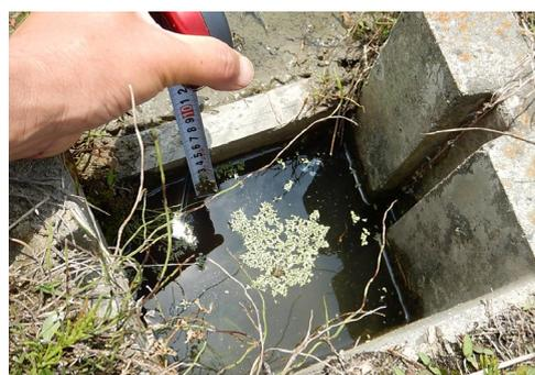
図4.1.7 水田水面との水位差5cmまで堰上げた排水路
